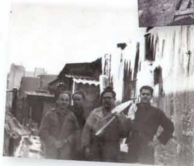
Treballadors al pati de la fàbrica Martí, Llopart i Trench en la gelada de del febrer de l'any 1956.
