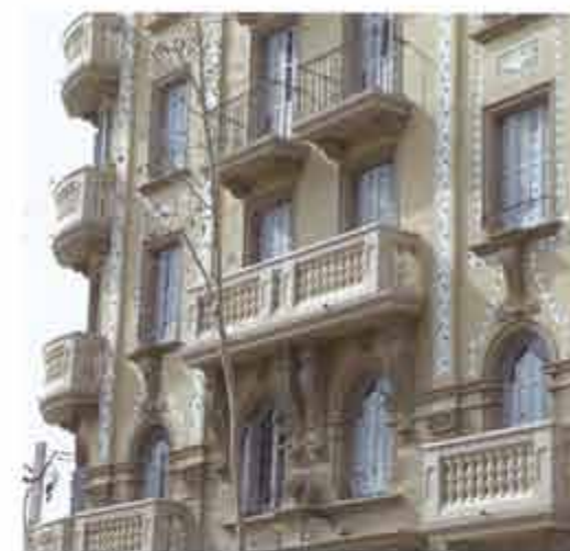
FOTO 10 La Casa Bonica. És la Casa Antònia Serra i Mas, construïda el 1926 per l'arquitecte Ramon Puig i Gairalt.
