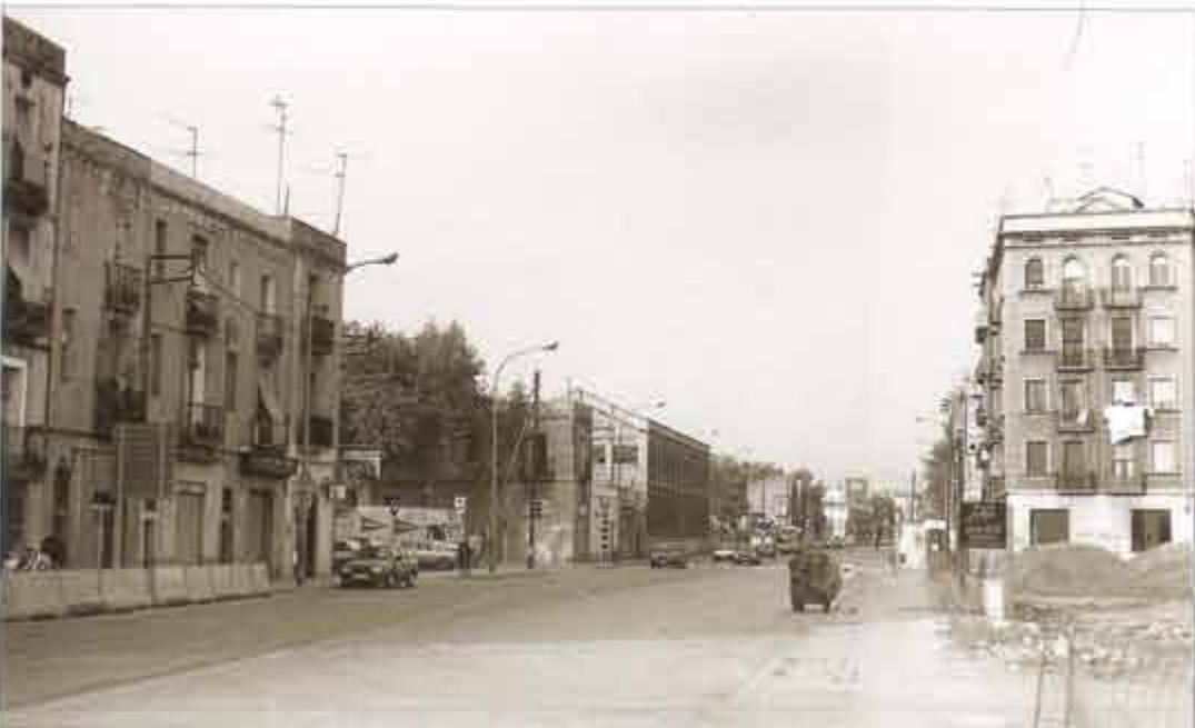
Enderrocament d'habitatges. Al fons a l'esquerra, la fàbrica Oliva Artés.
