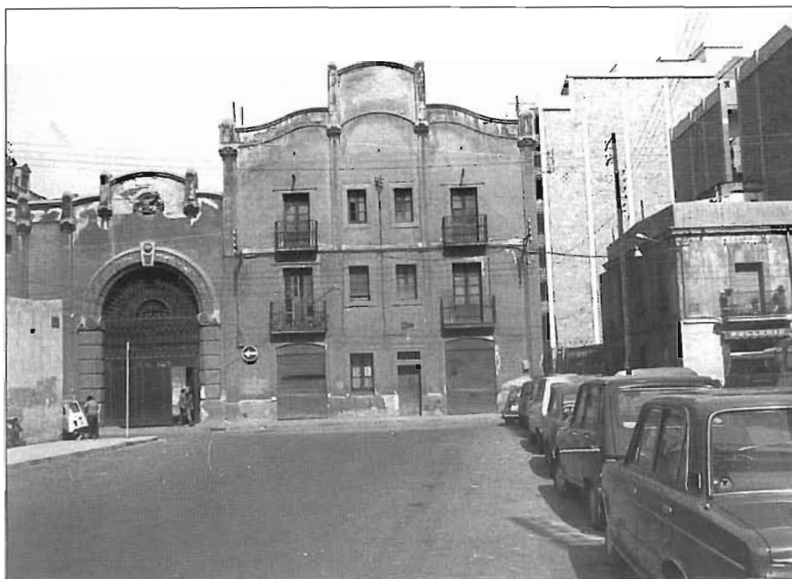
Can Felipa al 1975, quan ja estava abandonada
