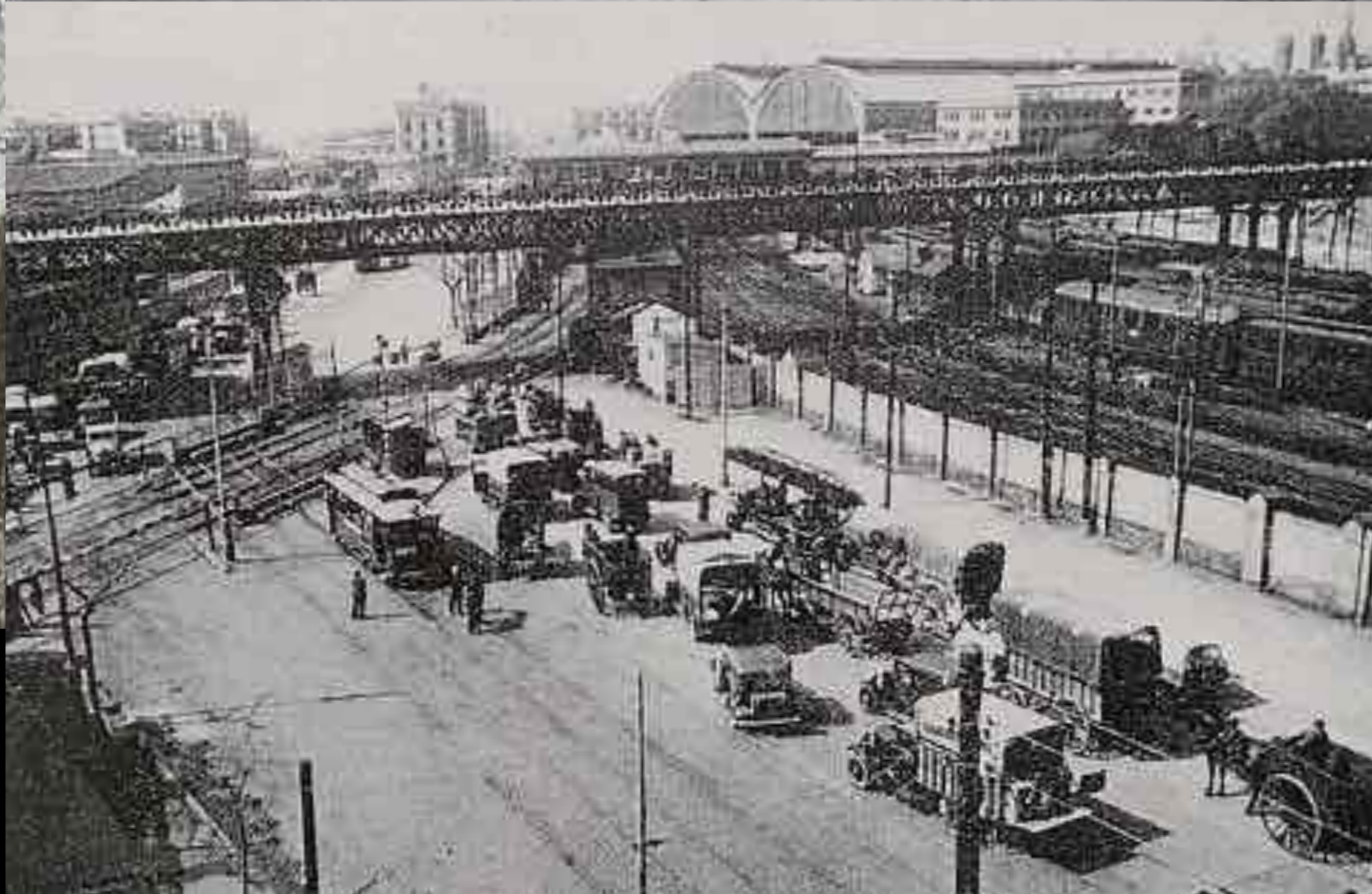
A sota, cues de vehicles al pas a nivell de l'avinguda d'Icària ⑪ esperen que passi el tren.
