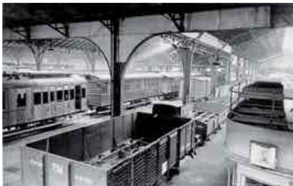
Construcció de trens dins la factoria de Macosa, 1941.
