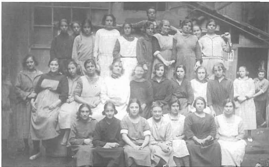
Obres de Can Saladrigas, en plena Guerra Civil. La foto és del 4 de gener de 1937 (DONACIO DE GLORIA BRAU)
