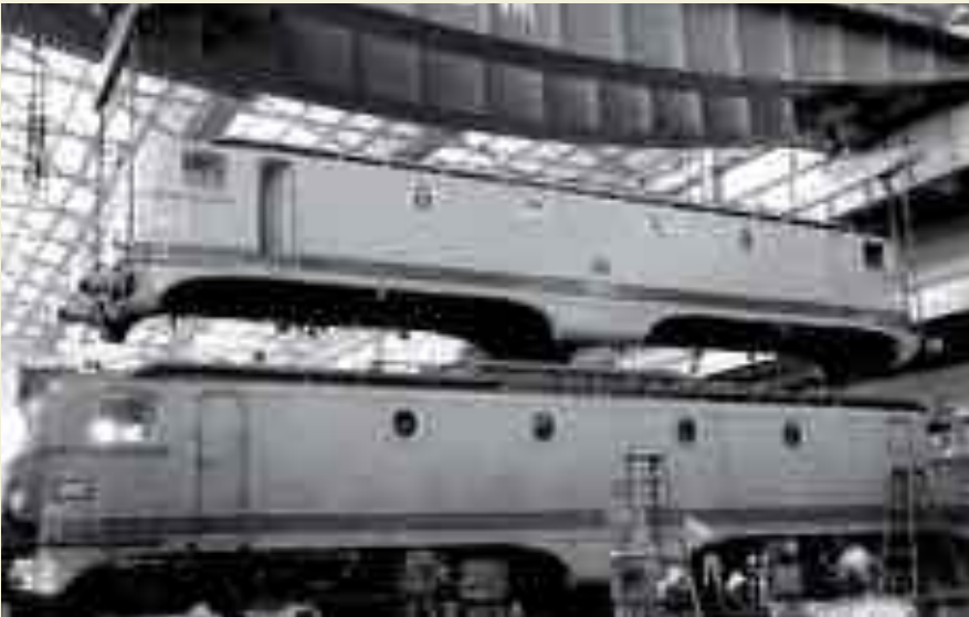
Material ferroviari en construcció dins de Macosa 9.
