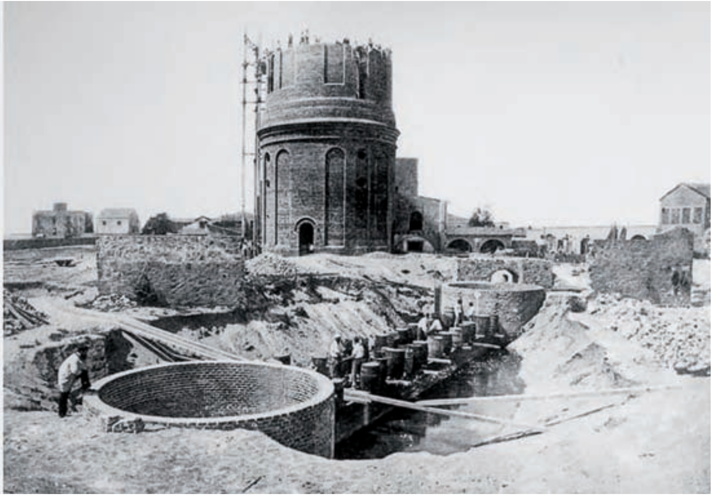
↑ Imatge de la torre en construcció. En primer pla es veuen els dipòsits per emmagatzemar l'aigua.
