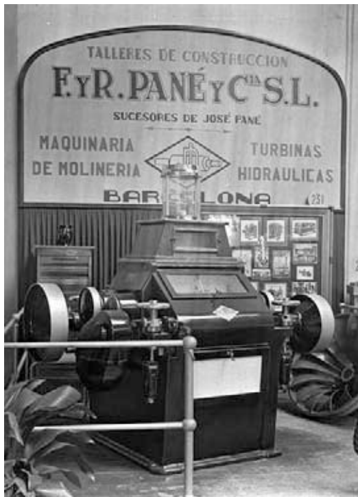
Màquina per netejar les sèmoles construïda als tallers de José Pané.
