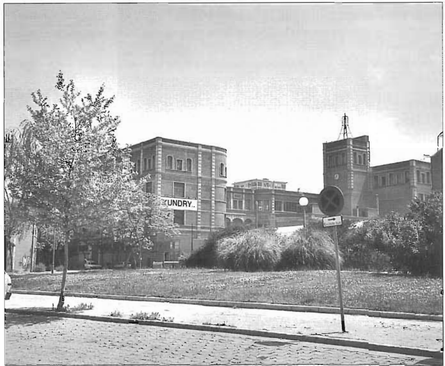
El Vapor de la Llana, al carrer de Sant Joan de Malta
